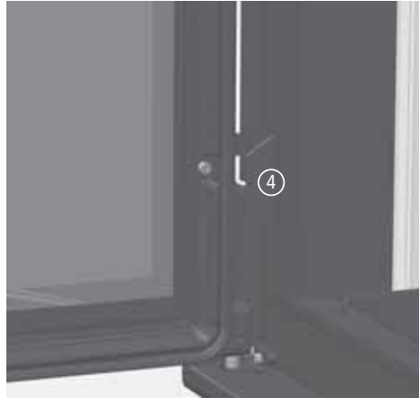
Abb. 2.41 Feuertür einhängen mit Türfeder
