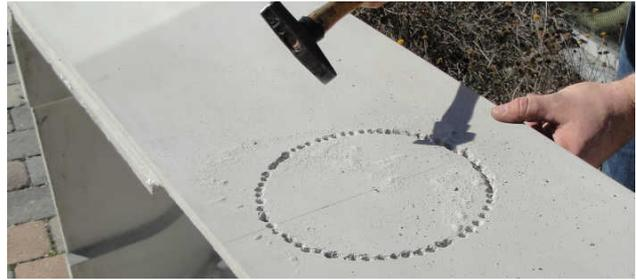
Abb. 2: Ausbruch herstellen mit dem Bohrer
