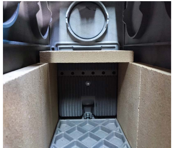
3. 1 der 3 oberen Platten oben platzieren, nach hinten schieben
