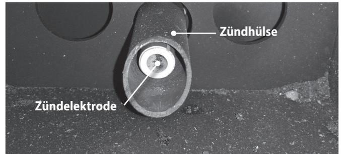
Dabei wird die in die Zündhülse einströmende Luft stark erhitzt. Diese stark erhitzte Luft strömt aus der Zündhülse in die **Brennerschale (5)** und entzündet die darin befindlichen Pellets.
