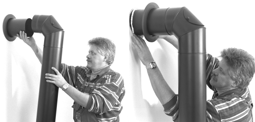
Abb. 10: Anschluss Rauchrohr am Schornstein
