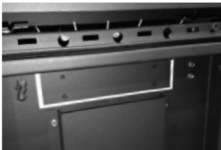
Abb. 3.3 Verschlusschrauben der Messöffnung
