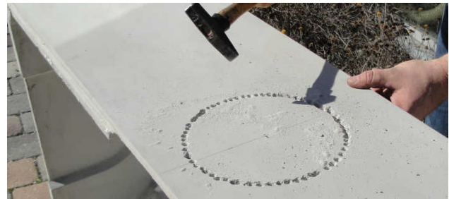
Abb. 11: Ausbruch herstellen mit dem Bohrer
