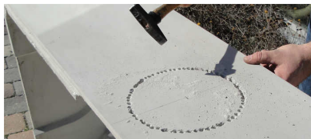
Abb. 17: Ausbruch herstellen mit dem Bohrer
