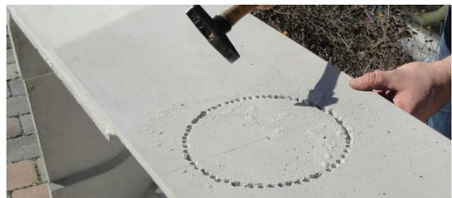
Abb.2: Ausbruch herstellen mit dem Bohrer
