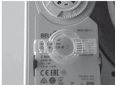
Abb. 3.20 Kupplung entriegelt
