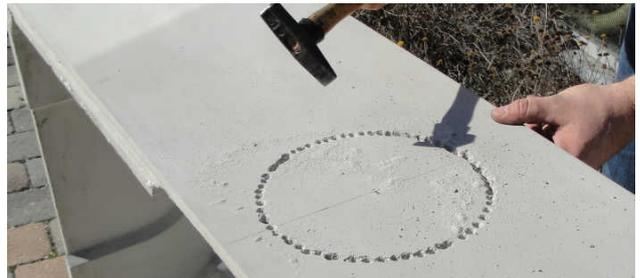
Abb.2: Ausbruch herstellen mit dem Bohrer
