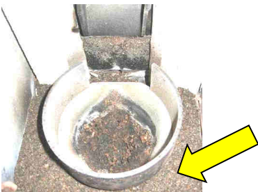
Abb. 46: Asche im Brennraum
