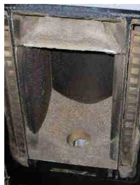
Abb. 111: Normale Verschmutzung (trockene Flugasche).
