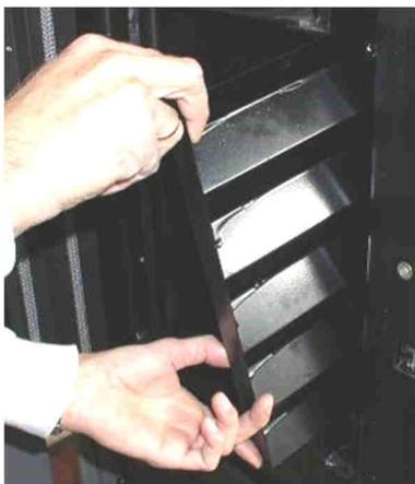
Abb. 135: Entnahme Turbulator
