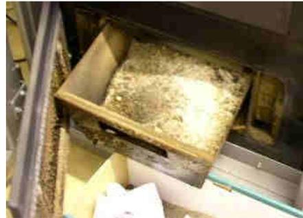
Abb. 110: Entnahme der Aschelade
