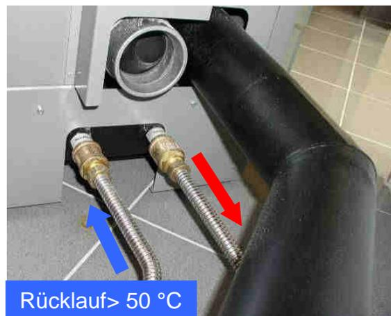
Abb. 43: Hydraulische Anschlüsse BM 01
