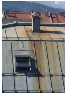
Typische Bilder von Kaminschäden, verursacht durch eine schlechte Verbrennung, Zugverhältnisse oder einer ungeeigneten Abdeckung.
