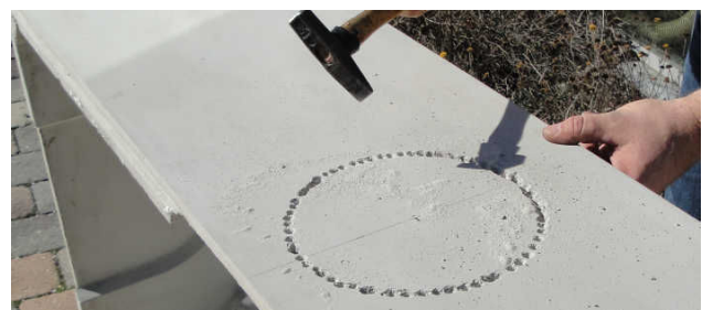
Abb. 20: Ausbruch herstellen mit dem Bohrer
