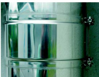
Von Nennweite 400–600 mm sind die Steckverbindungen des Außenmantels zylindrisch ausgebildet und werden mit einem Klemmband montiert. Ab Nennweite 400 mm muss nur das Innenrohr verdichtet werden.
