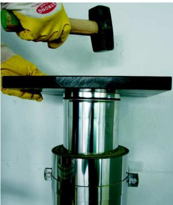
Das Innenrohr ist entsprechend der Abbildung zu verdichten.
