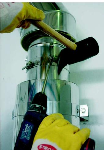
Um eine absolut druckdichte Verbindung herzustellen, muss nach dem Anziehen des Spannbandes mit dem Gummihammer vorsichtig umlaufend auf die Verbindungsstelle „geschlagen“ werden.
