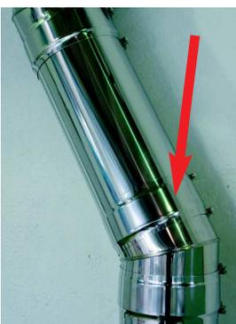
Bei der Montage eines Verzuges sind alle Verbindungen, beginnend ab der Verbindung zwischen senkrechter Abgasanlage und erstem Bogen, mit Klemmbändern zu sichern. Eingeschlossen hiervon ist ebenfalls die Verbindungsstelle am Fußteil offen als Zwischenstütze (siehe auch nachfolgendes Foto).
