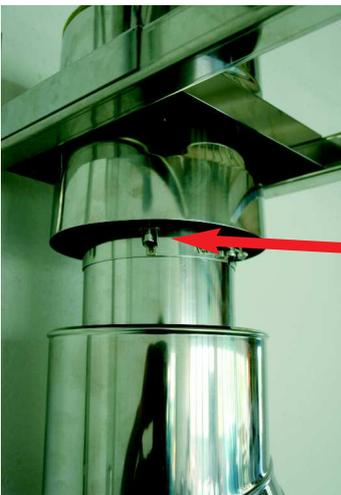
Über dem zweiten Bogen des Verzuges ist immer ein **Fußteil offen als Zwischenstütze** zu montieren.
