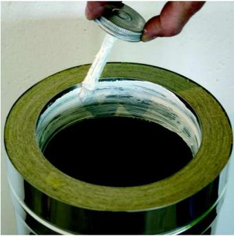
Vor der Montage sind Muffenseite und Einsteckseite auf Verunreinigungen und Beschädigungen zu überprüfen.
