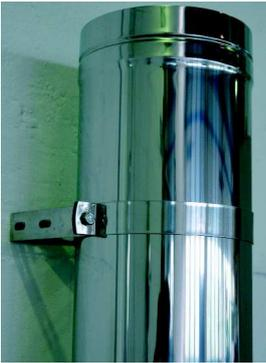
Der Aufbau der Abgasanlage bis zum VERZUG erfolgt wie unter Schritt 1 bis Schritt 3 beschrieben (siehe Seite 2). Auch hier ist bei der Montage der einzelnen Elemente die Dichtpaste CERAMO zu verwenden.
