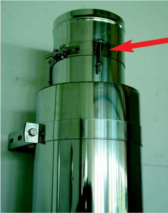
Danach wird das Spannband direkt unterhalb der Muffe befestigt.
