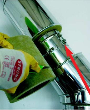
Anschließend ist die Dämmschale an die Schraubverbindungen des Innenrohres anzupassen (aussparen).
