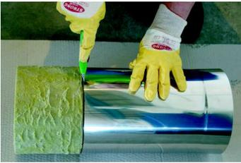
Nach dem Kürzen des Außenmantels ist die Dämmung ebenfalls zu kürzen und zu entfernen.
