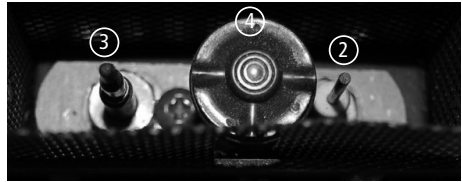
Abb. 6.1 Flammenwächter, Pilot-Brenner und Zünddorn
