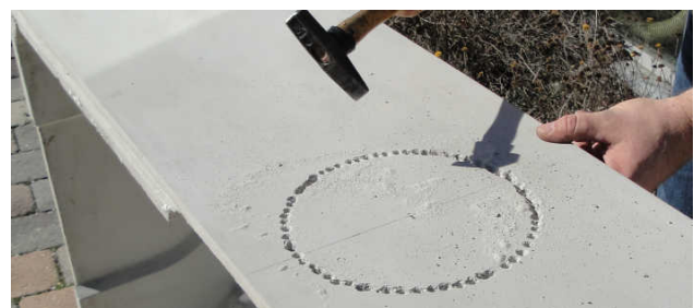
Abb.2: Ausbruch herstellen mit dem Bohrer
